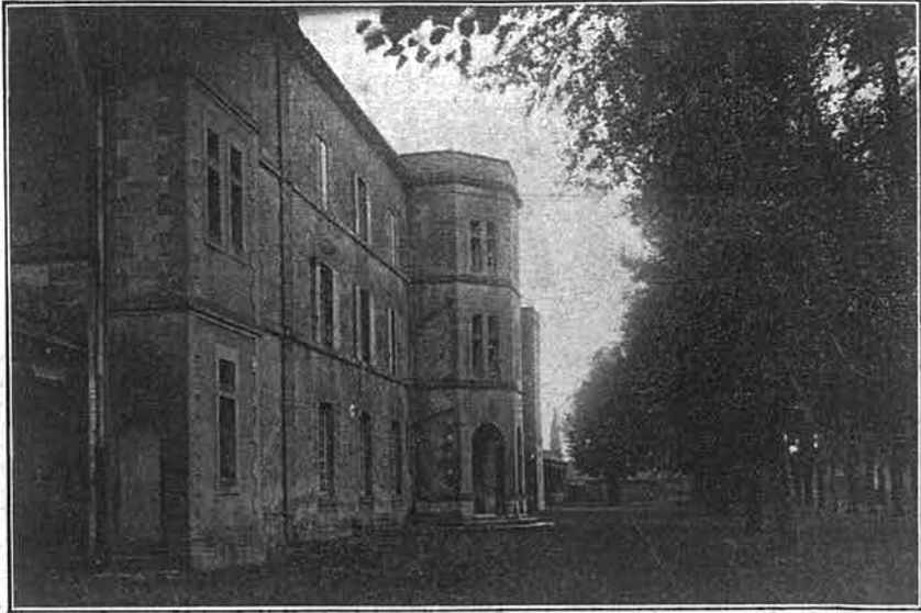
Façade sur la terrasse
