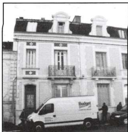
Après les travaux, notre immeuble a repris bel aspect. (photo sur rue après restauration)
