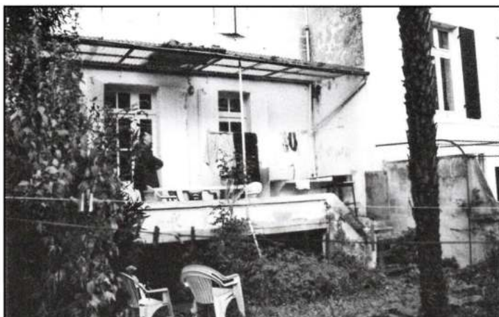
Avant les travaux, Bernard Marty évalue la situation. (photo côté jardin avant restauration)
