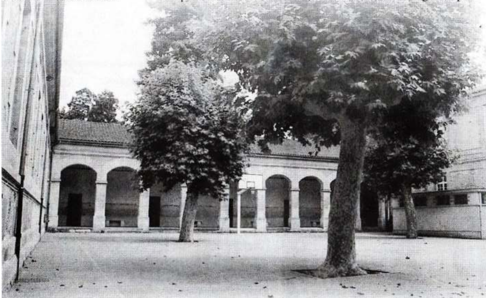
Le chantier débutera en fin d'année et se poursuivra pendant sept ans, sans qu'à aucun moment les cours ne soient interrompus.
